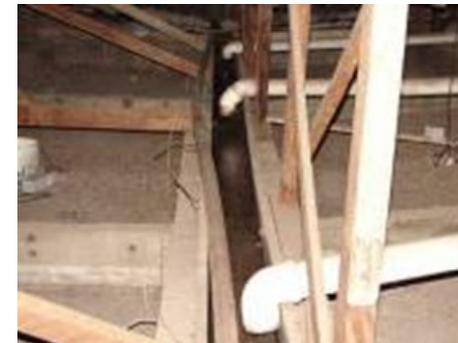
Fig. 17/18 – Exemplos das calhas de zinco sem caimento suficiente, impedindo o deslocamento da água seguido de corrosões e infiltrações para o interior do prédio.
