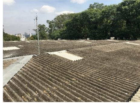
Fig. 1/2 – Componentes da cobertura - estruturais em madeira e uso indevido de telhas com amianto.
